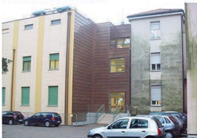
VISTA ANTERIORE CON UNIONE AMPLIAMENTO E RISTRUTTURAZIONE
