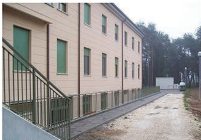
VISTA POSTERIORE - EDIFICIO AMPLIATO
